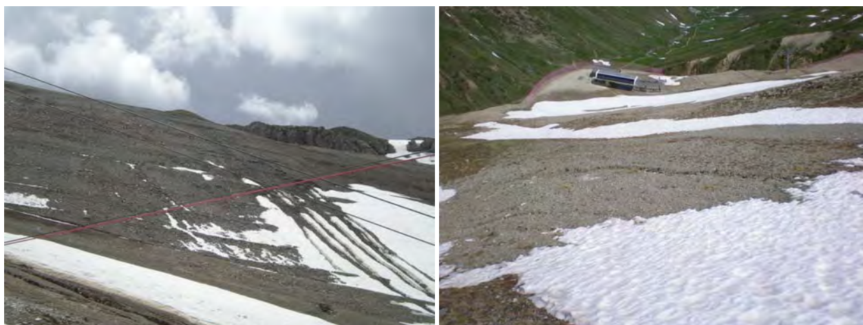
Figure 3.13 e 3.14 - Impianti in Val Federia: notare la pressoché totale assenza di vegetazione e di interventi di ripristino ambientale. Il processo erosivo è in atto (Foto Bassi).
